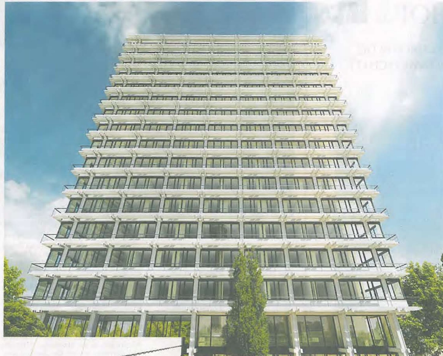
320 Appartements passen in den einstigen IOC-Sitz am Münchner Olympiazentrum.
